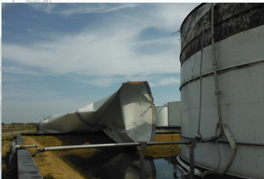
Europoort, Nederland, 19 juli 2016, methanoltank (Ø 29 meter)
